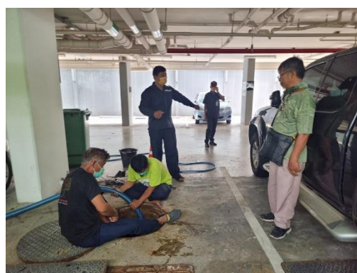
รูปที่ 9 การสูบน้ำและบ่อดักไขมัน
