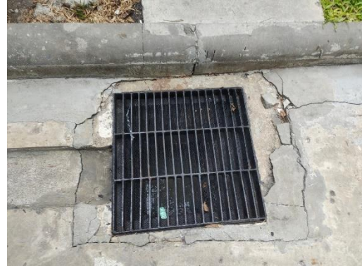
รูปที่ 14 ตะแกรงกรองเศษขยะครอบคลุมท่อระบายน้ำ
